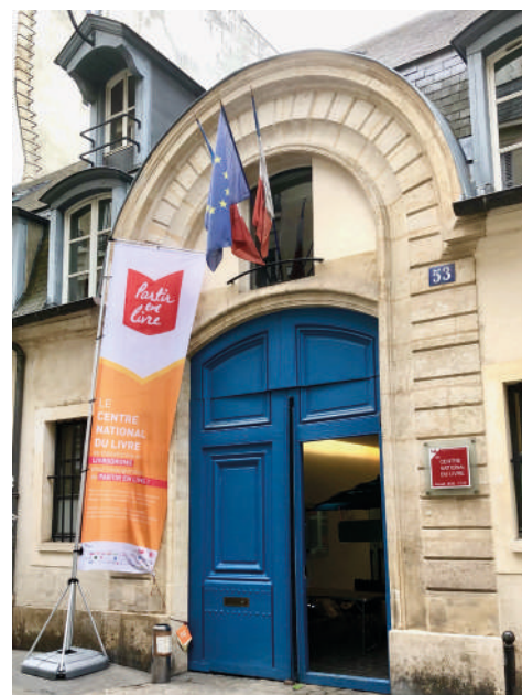
Entrée inauguration © CNL
